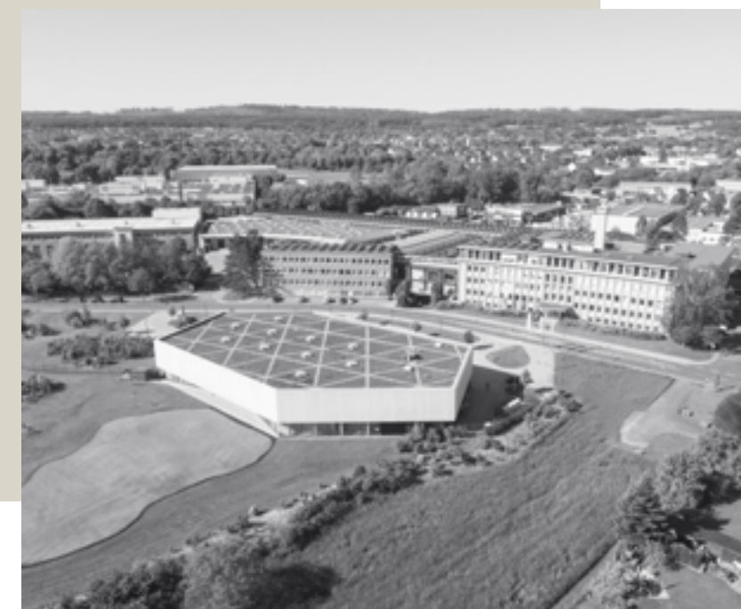
Firmenzentrale der JAB ANSTOETZ Group in Bielefeld
